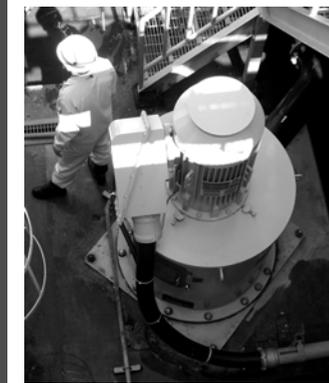
津波で浸水し使用不能となった冷却用海水ポンプ (同)
