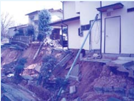
▲大震災で崩落した市内住宅地
