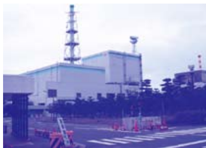
▲東海第2発電所(東海村)
